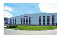
大福自動搬送設備(蘇州)
