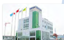
大福(中国) 自動化設備
